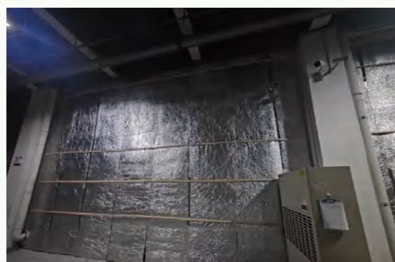
於牆面加裝保溫棉
